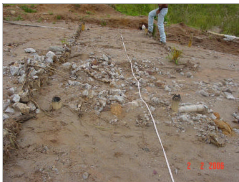
Figura 23: Aspecto de partículas mais grosseiras nos sedimentos da erosão, no coletor da voçoroca sem intervenção.
