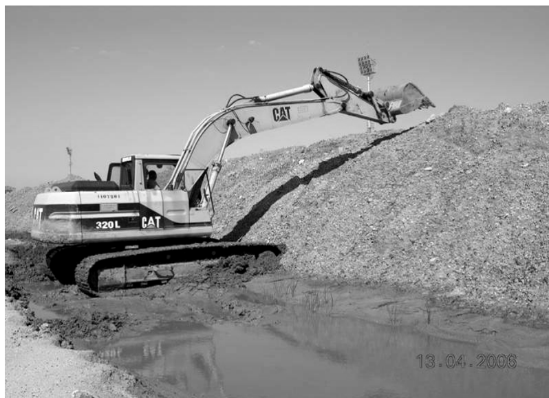
Figura 5: Coleta de amostras do resíduo em uma das pilhas formada pelo material retirado para construção das colunas de sustentação.
