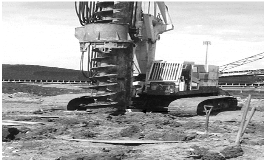
Figura 4: Retirada do substrato para a construção das colunas de brita no pátio de minério da CSN no Porto de Itaguaí-RJ
