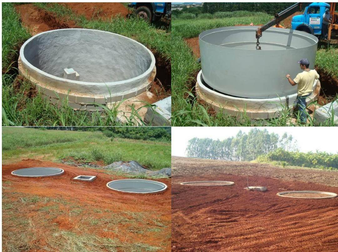
Figura 3 – Representação da estrutura de alvenaria que sustenta os lisímetros e e preenchidos com solo após instalação (Flumignan, 2011)
