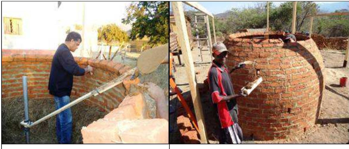
FIGURA 13: CONSTRUÇÃO DO FORNO FIXO TIPO RABO-QUENTE
