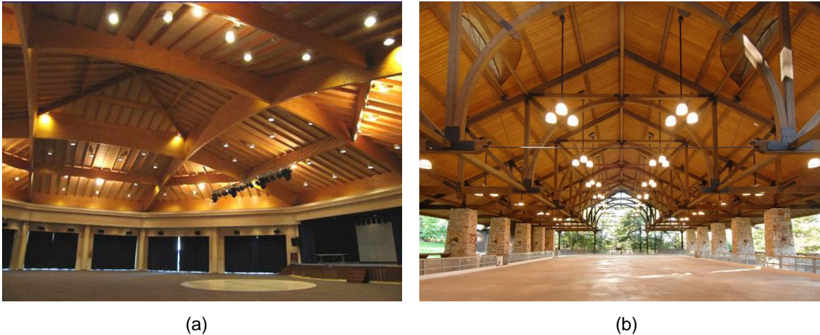
Figura 13 - MLC no Hotel San Valentim, Chiclana / Espanha (a); MLC utilizada em cobertura de barracões(b)
