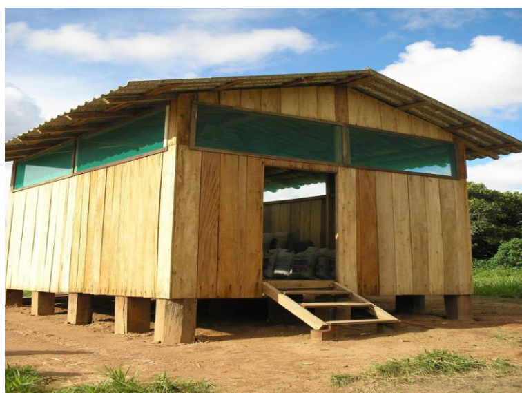
FIGURA 5. BARRACÃO DE ARMAZENAGEM – FAZENDA SÃO NICOLAU. Fonte: Autora, 2008.
