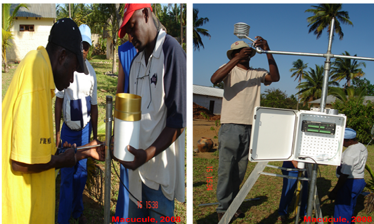
FIGURA 6. MONTAGEM DA ESTAÇÃO METEOROLÓGICA AUTOMÁTICA
