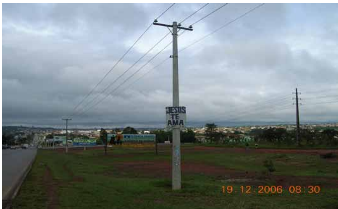
Figura n.º. 26 – Foto Panorâmica da área, às margens da EPTG, próximo à entrada da Rua 01-A
