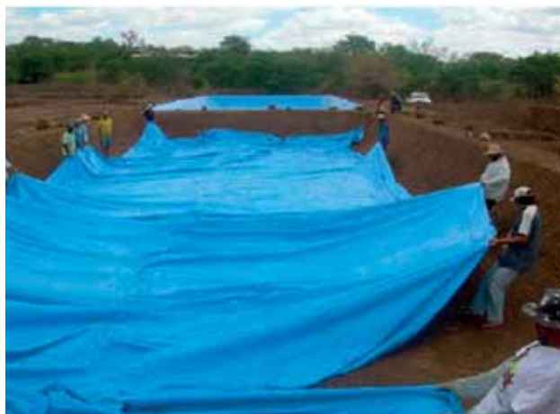
Foto 18: UD de Amparo/PB. Impermeabilização dos viveiros
