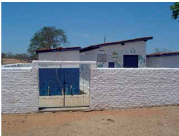
Foto 35: Sistema de dessalinização em Serra Branca/PB
