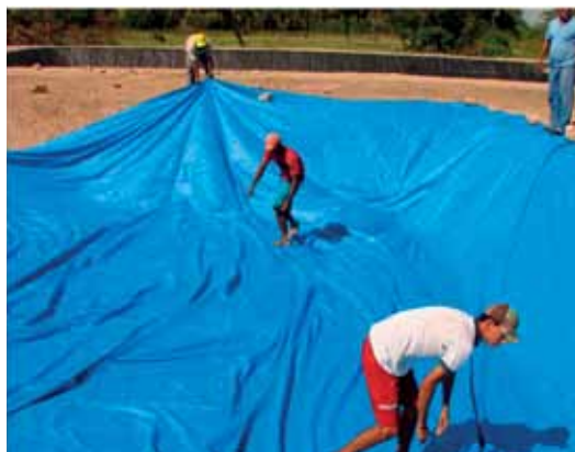
Foto 59: Processo de aplicação da geomembrana (passo 3)
