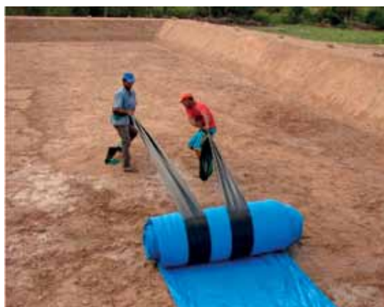
Foto 57: Processo de aplicação da geomembrana (passo 1)
