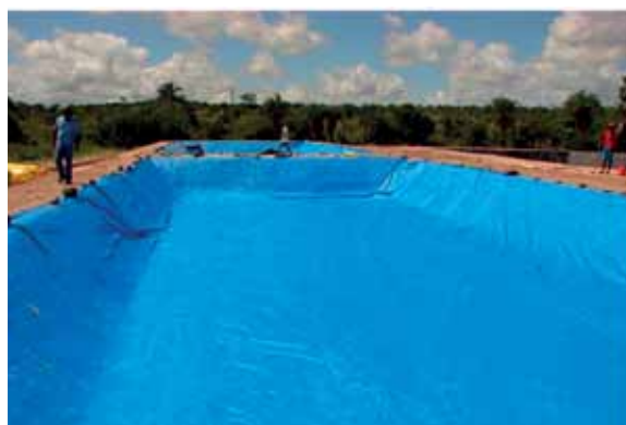
Foto 60: Processo de aplicação da geomembrana (passo 4)
