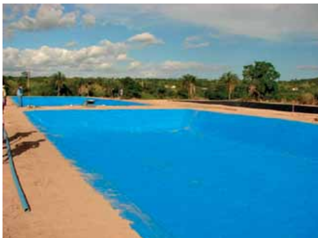
Foto 43: Viveiros revestidos com geomembrana
