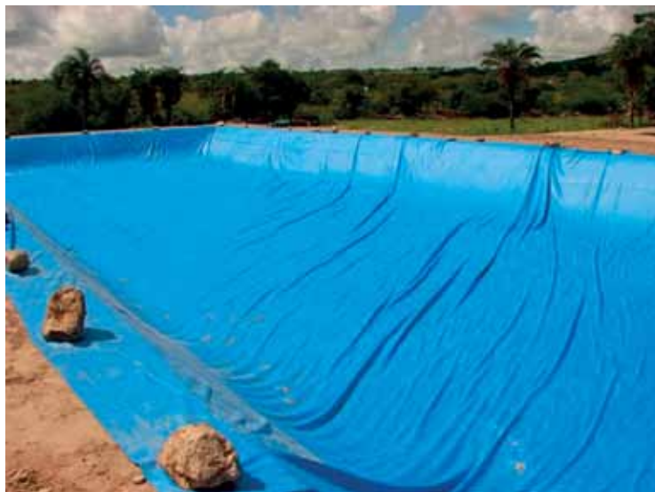
Foto 61: Lastreamento da geomembrana na vala de ancoragem
