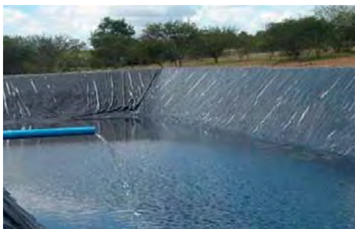
Foto 63: Abastecimento de água
