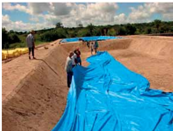
Foto 58: Processo de aplicação da geomembrana (passo 2)
