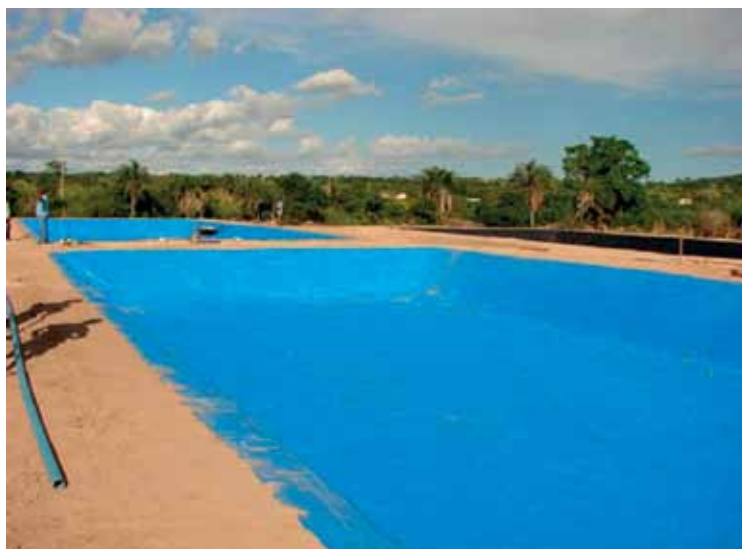
Foto 62: Fixação da geomembrana na vala de ancoragem
